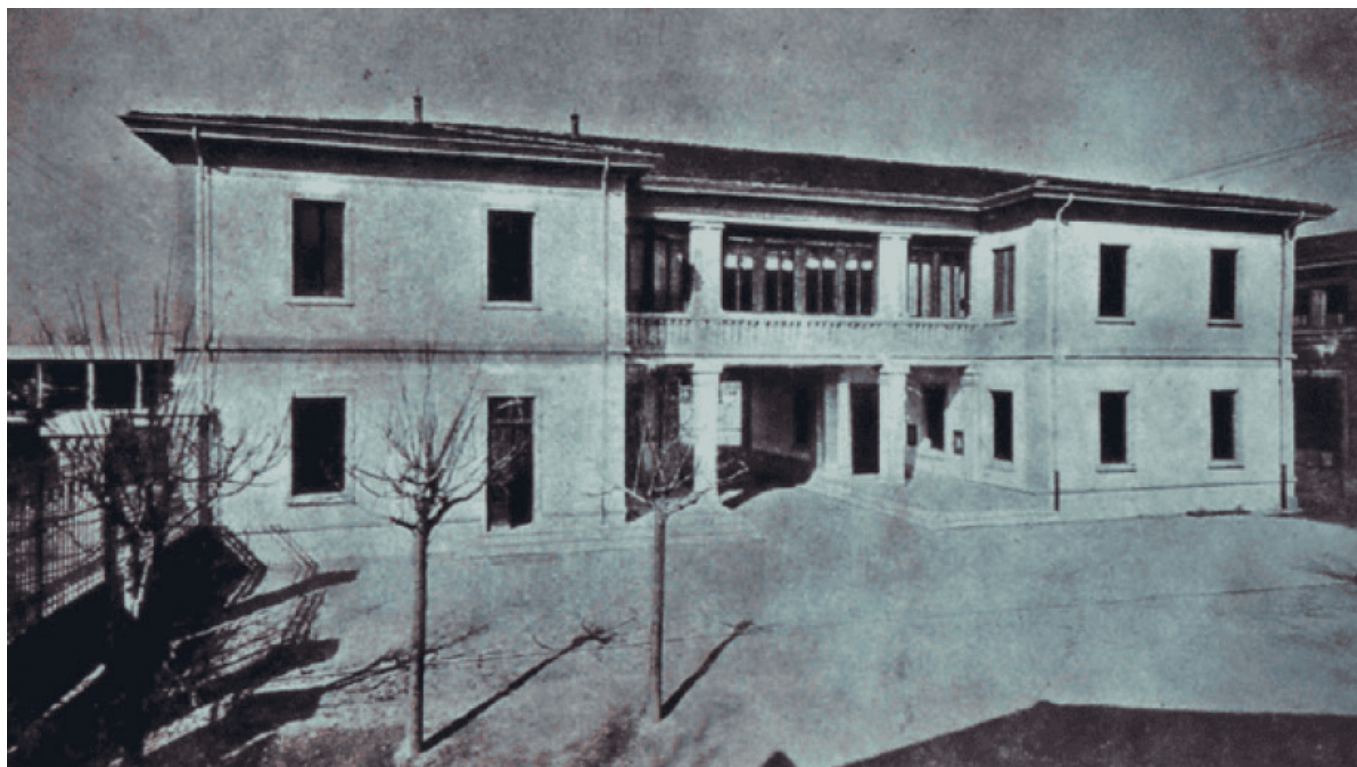
La sede amministrativa Sipe attuale ingresso del San Camillo
